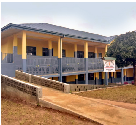
Dit schoolgebouw is door een hellingbaan nu ook toegankelijk voor leerlingen die minder mobiel zijn.
